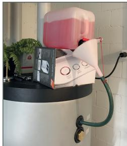
**ACHTUNG:** Das Entkalkungsmittel reagiert umgehend und bildet Gasblasen, welche das Wasservolumen im Boiler drastisch vergrößern. Nach Einfüllen von ca. 40 lt Entkalkungsmittel überläuft der Boiler bereits (was für eine Sauerei!!) und es musste zusätzlich Wasser abgelassen werden. D.h. das Wasservolumen vergrößert sich um ca. 10% wenn das Entkalkungsmittel reagiert.
