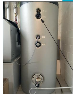
Wasser ablassen bis Unterkannte Thermometer-Stutzen
